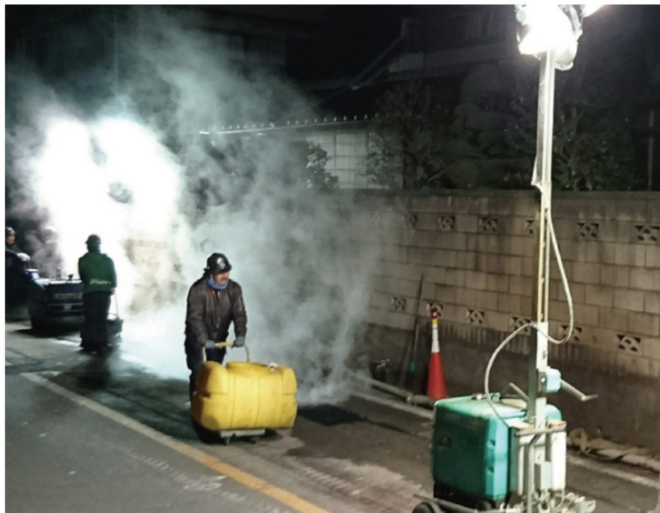
吐く息も凍る真冬の深夜に建設労働者は道路を補修し、生活基盤を守っている（30年1月 川越市市場で福永県議撮影）
