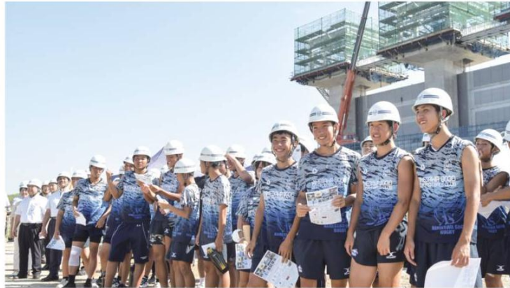
調節池の建設現場を見学する滑川総合高の生徒たち
